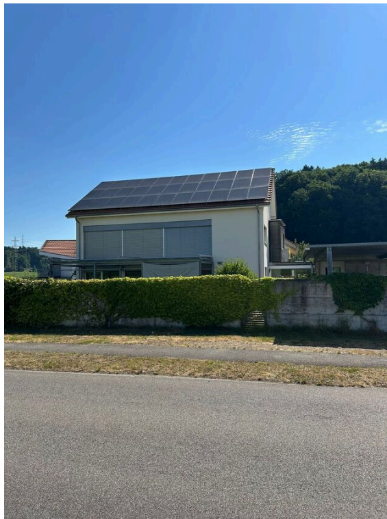
Strassenseite mit Solaranlage
