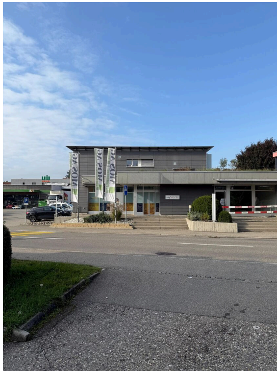
Vorderseite Gebäude Wydenstrasse 15
