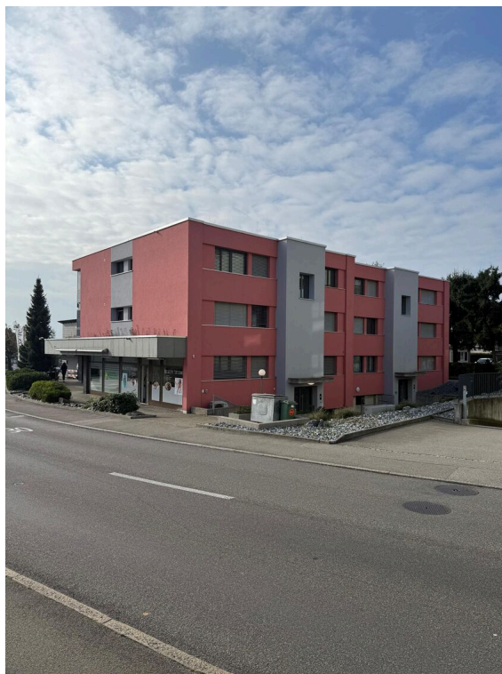
Vorderseite Gebäude Wydenstrasse 17
