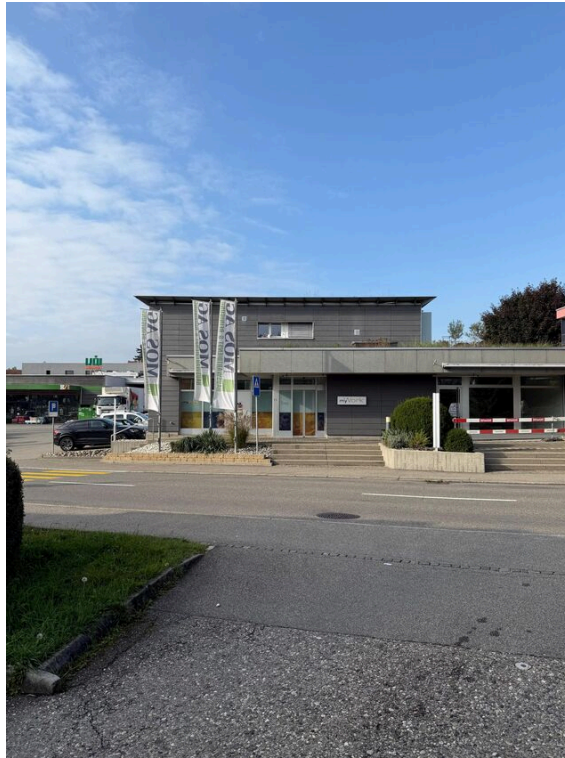
Vorderseite Gebäude Wydenstrasse 15
