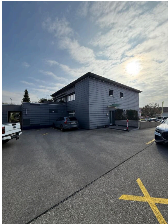
Rückseite Gebäude Wydenstrasse 15
