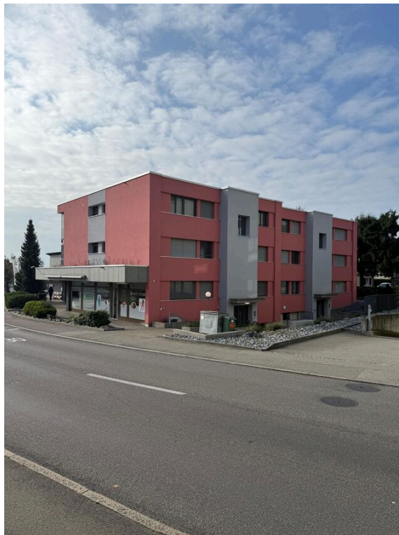
Vorderseite Gebäude Wydenstrasse 17
