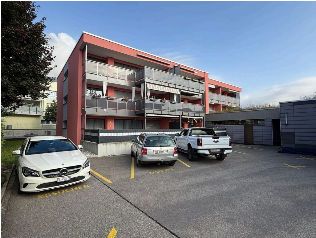
Rückseite Gebäude Wydenstrasse 17
