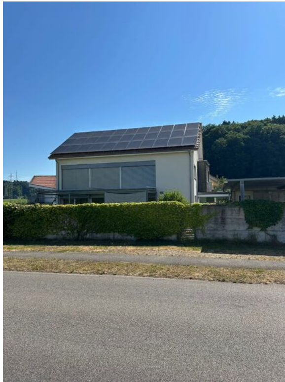
Strassenseite mit Solaranlage
